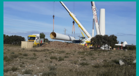
Photo : démantèlement du premier parc éolien français à Port-la-Nouvelle en 2019. 96% des composants ont été recyclés.
